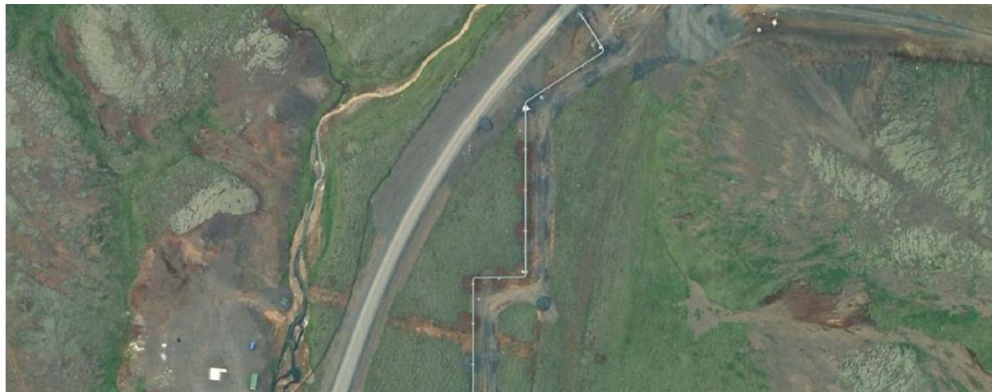
Mynd 12.7 Hefðbundnar lagnir ofanjarðar með Z-útfærslum séó úr lofti á framkvæmdatíma.
