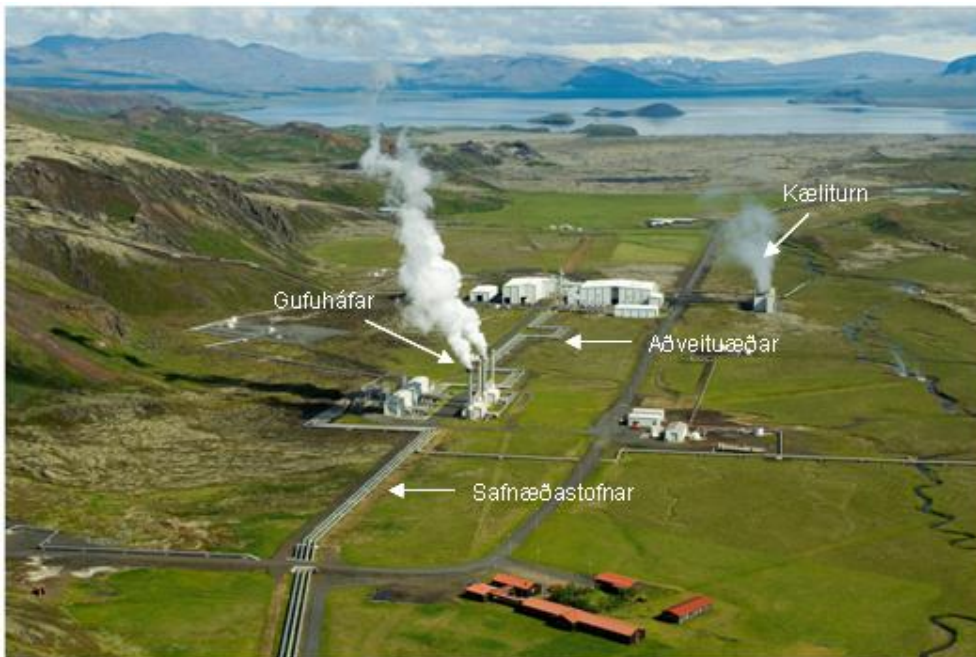
Mynd 12.11 Dæmi um aðveituæðar. Myndin er tekið á Nesjavöllum og sýnir safnæðar að skiljustöð, gufuháfa og aðveituæðar að stöðvarhúsi. Á myndinni sjást einnig fjórir gufuháfar.
