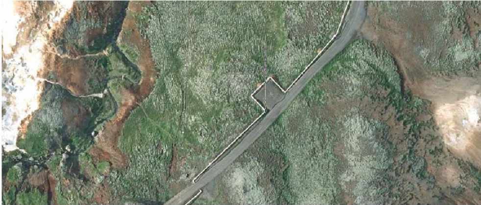
Mynd 12.8 Hefðbundnar lagnir ofanjarðar séð úr lofti. U-útfærsla fyrir miðri mynd.
