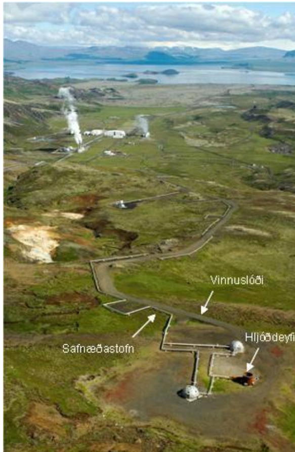
Mynd 12.9 Dæmi um borteig, hljóðdeyfi, safnæð og vinnuslóða meðfram lögn. Mynd er tekin á Nesjavöllum.
