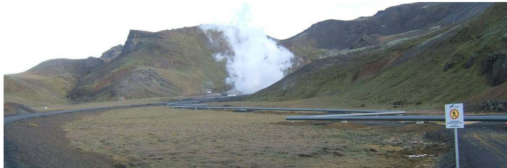
Mynd 12.6 Hefðbundin lögn ofanjarðar með Z-útfærslum
